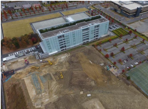
平成 28 年 11 月 着工時の全景写真
