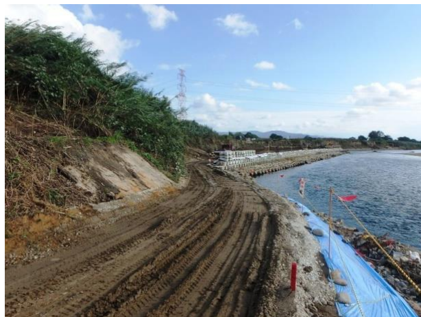
No. 4 【護岸他補修工事】
