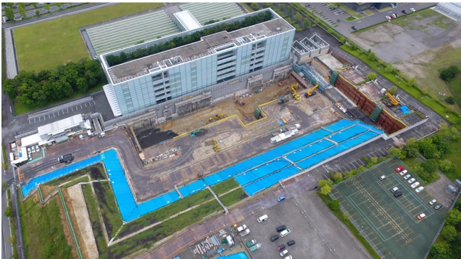
平成 29 年 7 月 造成工事完了
