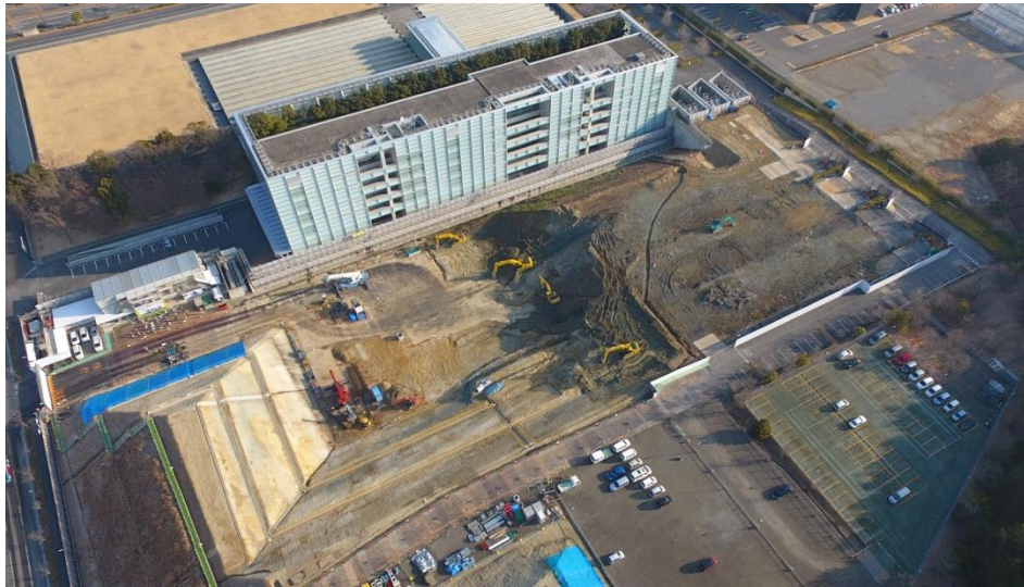
平成 29 年 3 月 造成工事 5 ヶ月経過
