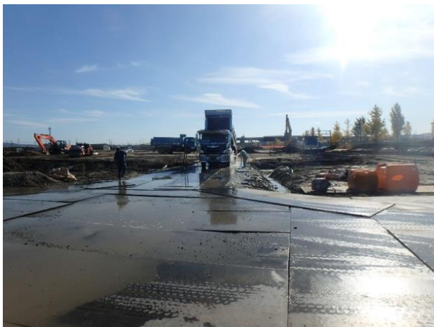
No. 3 【街づくり開発工事】
