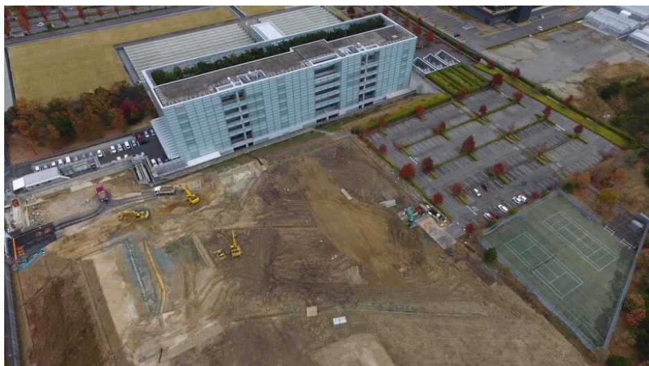
平成28年11月 着工時
